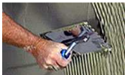
Równomierne rozprowadzanie kleju.
