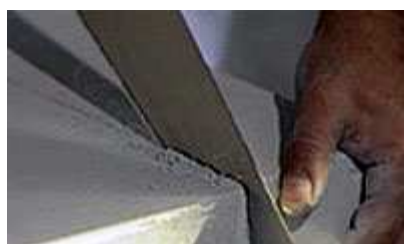
Cięcie płyty do porządnego wymiaru.
