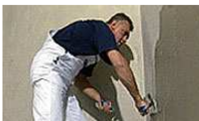
Nakładanie kleju na ścianie.
