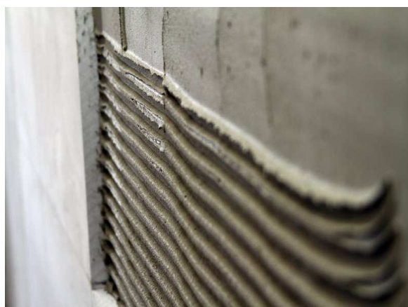
zaczesywanie (fot. 2)
