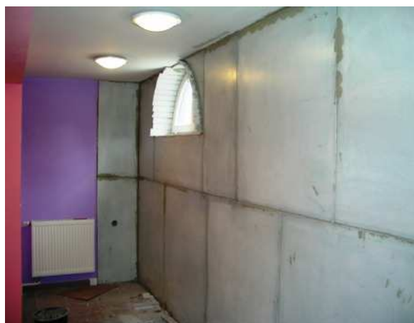
zakładki na ścianie działowej - podczas montażu
