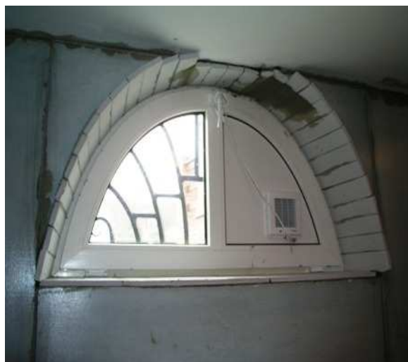
klejenie nietypowego ościeża
