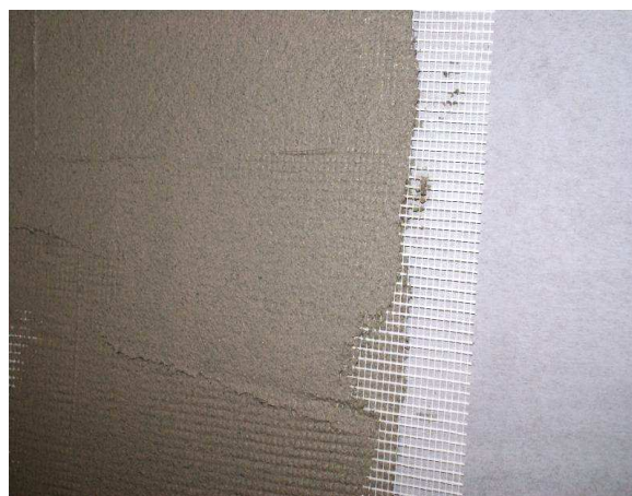
montaż siatki (fot. 6)
